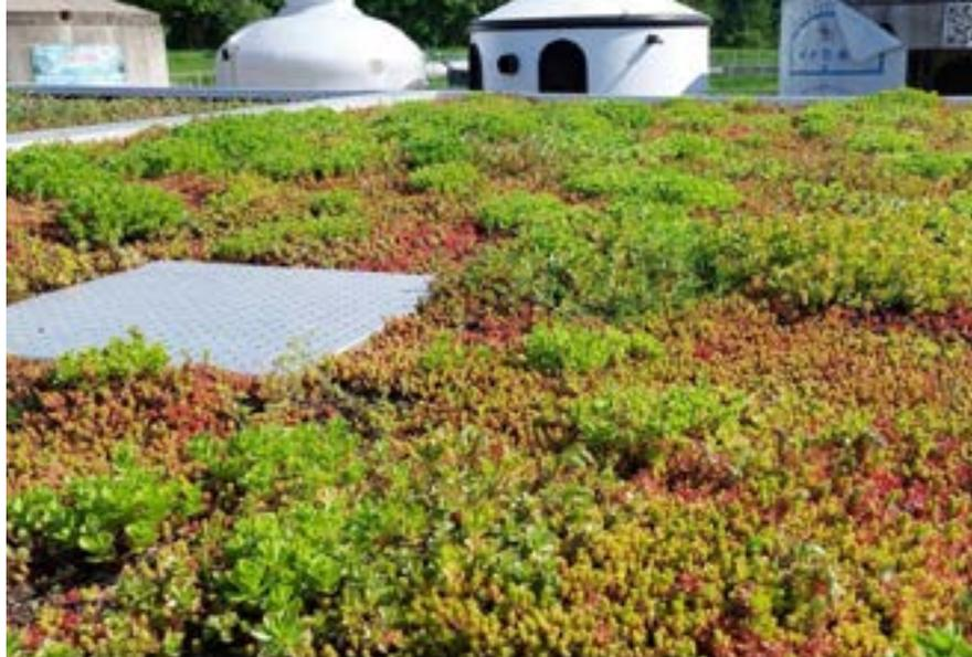
↑ Beispiel einer gleichmäßigen Pflanzenbedeckung auf einem Extensivdach. Diese bietet viele Vorteile, darunter eine bessere Wasserspeicherkapazität, eine verbesserte Kühlung der Umgebung und Beständigkeit des Daches selbst.
